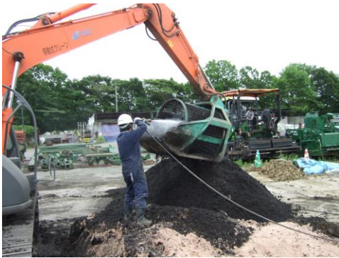
油とりクリーナーの希釈液で洗淨し油を分散・剥離させる
