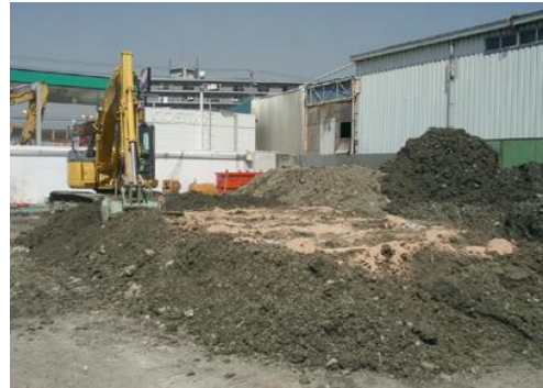
レメディエーターを散布し、後は重機等で良く攪拌混合する
